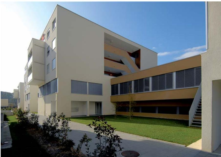
Celle-ci, réalisée en béton armé et en maçonnerie de terre cuite, est surmontée d'une toiture plate dotée d'un complexe isolant/étanche classique. Les façades sont enveloppées d'une couche isolante en polystyrène avec crépi de finition, constituant avec les vitrages isolants une enveloppe thermique efficace et conforme aux exigences actuelles.
